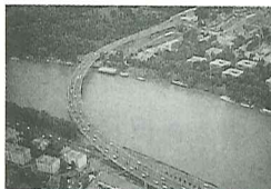
圖 13 曲線橋，跨距大，採用鋼結構，是理想的傳遞力量材料。
